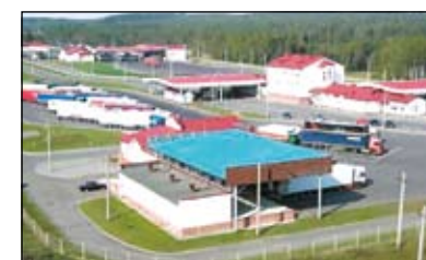
Пункт пропуска «Новая Гута»
